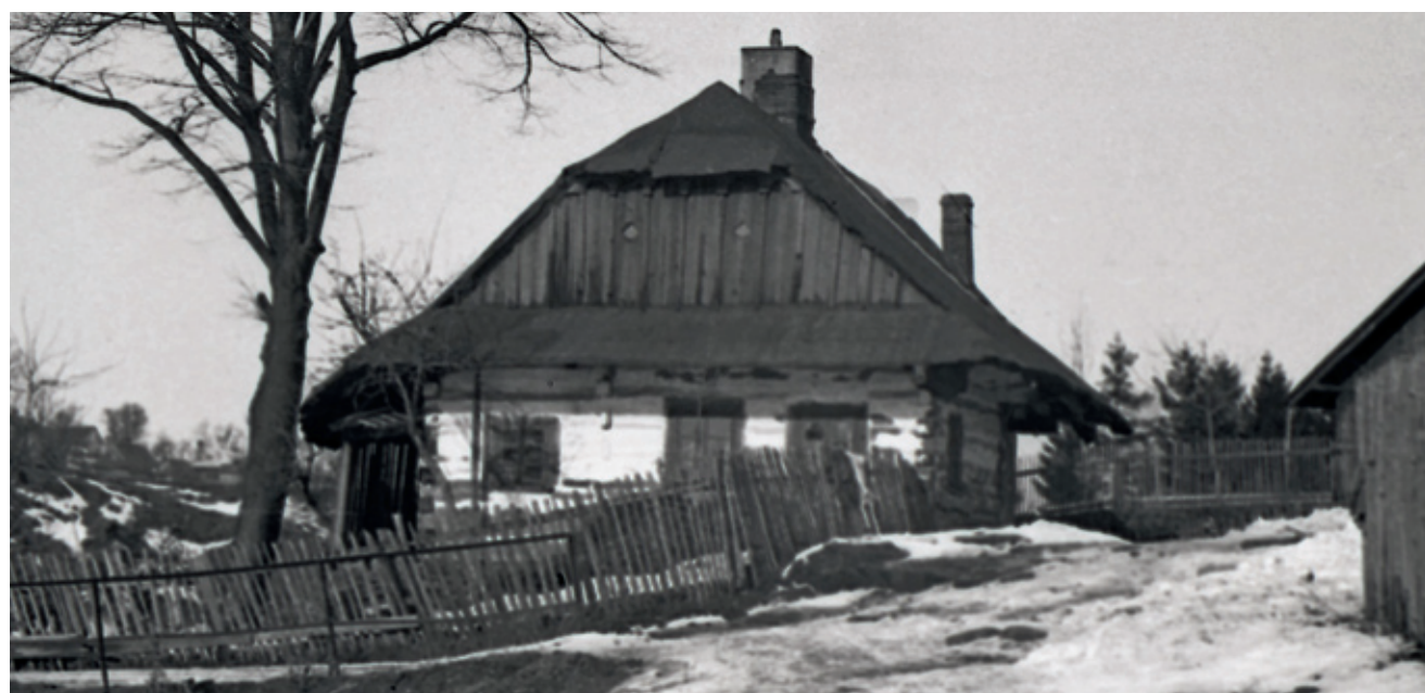
Dům čp. 20 U Skotnickigo. Před domem most přes Olzu, tzv. Staro ława – Dom nr 20 U Skotnickigo. Przed domem most przez Olzę, tzw. Staro ława
