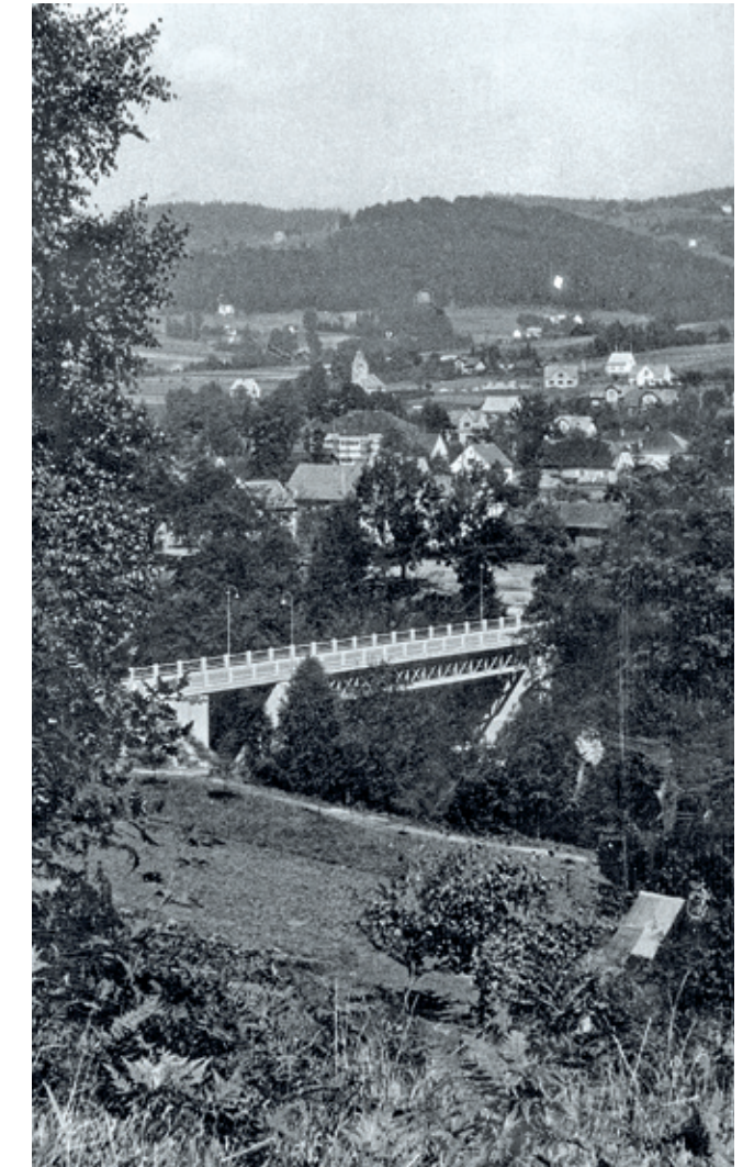
V roce 1956 byl postaven nový most přes Olzu — W 1956 roku wybudowano nowy most przez Olzę
