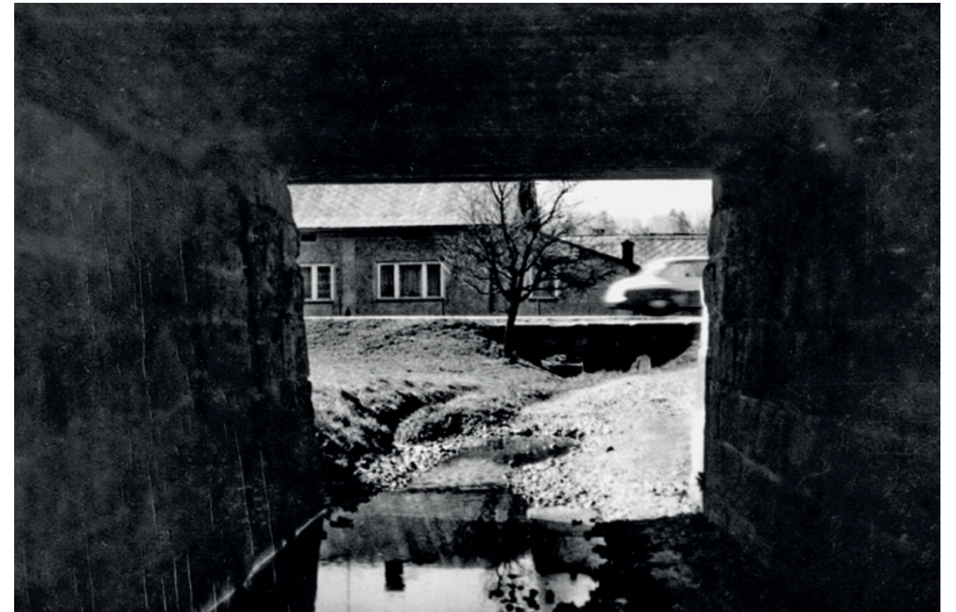
Pod mostkem. Dnes již neexistující průchod pod železniční tratí. Pro obyvatele Lyngů zkratka k nádraží – Pod mostkiem. Dzisiaj już nie istniejące przejście pod torami. Dla mieszkańców Łyngów skrót do dworca
