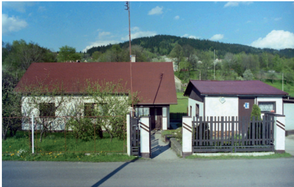
Domek Klimasů v roce 1997. Vpravo prodejna novin. V roce 2008 zbouráno kvůli stavbě koridoru — Domek państwa Klimasów w 1997 roku. Po prawej stronie kiosk z gazetami. Zburzony w 2008 roku z powodu budowy nowej trasy komunikacyjnej
