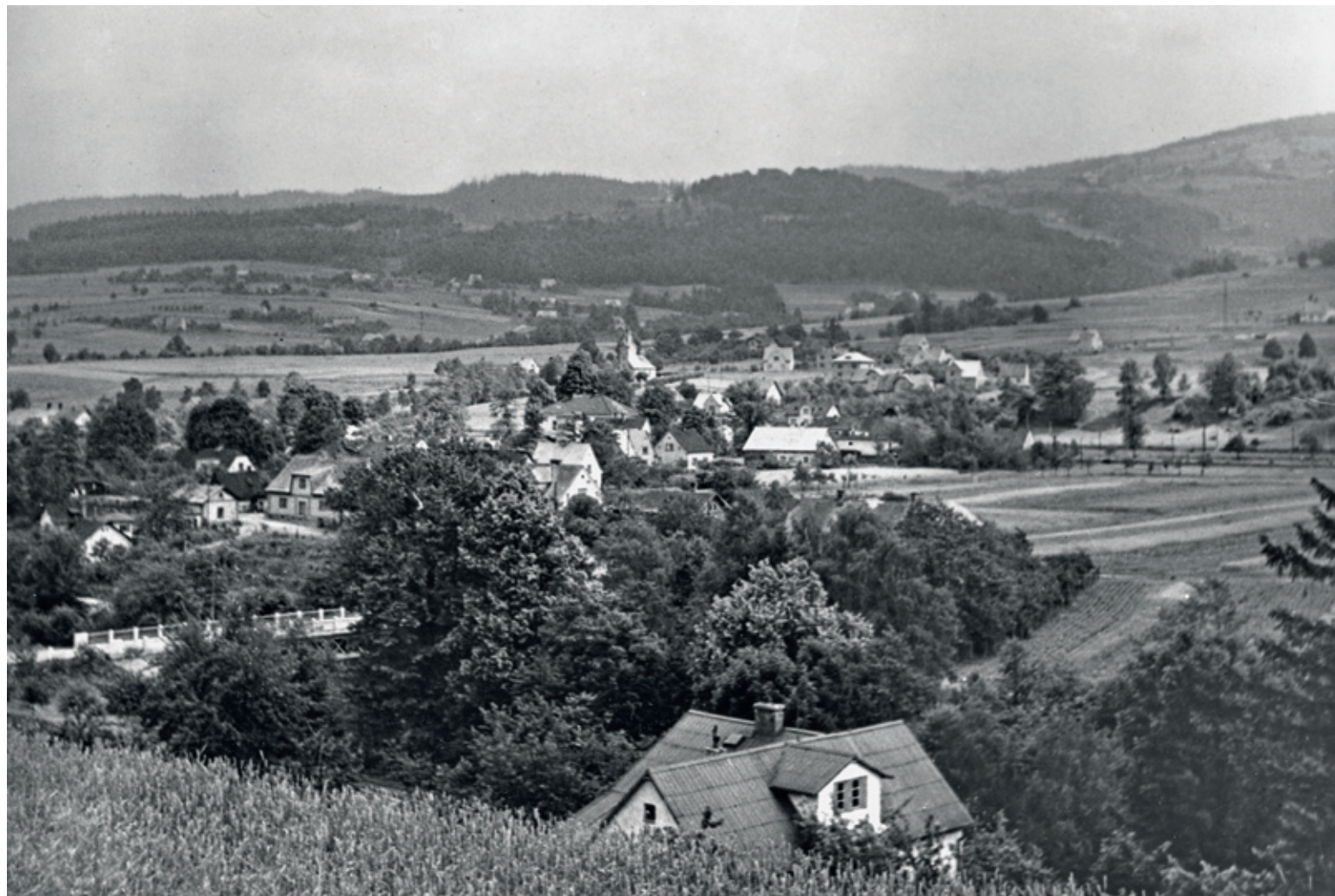
Pohled na Hrádek v roce 1968. Plocha pro stavbu samoobsluhy, pošty a MNV je připravena — Widok na Gródek w 1968 roku. Miejsce pod budowę sklepu samoobsługowego, poczty i MRN jest już przygotowane
