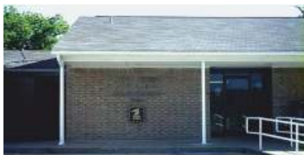
Budova pošty v Aldersonu
