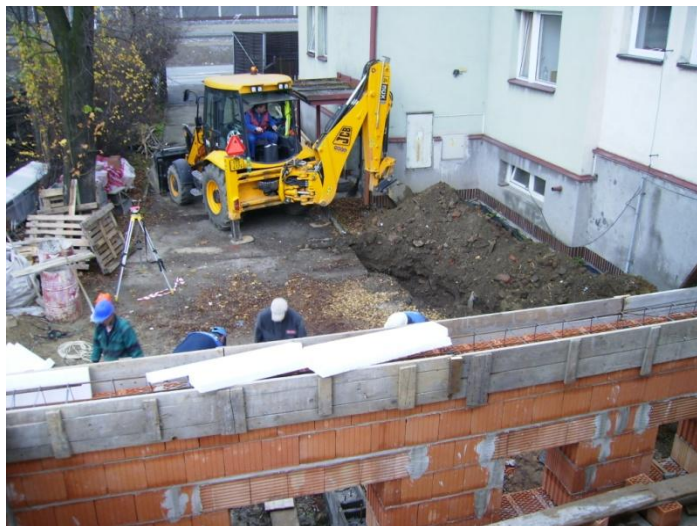
Budování přístavby školní kuchyně
